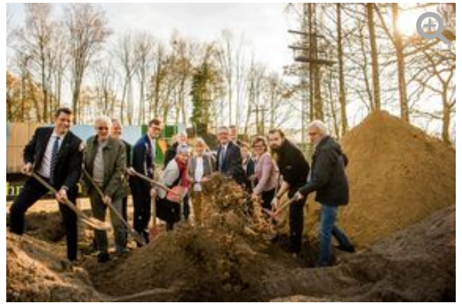
Am 25. Februar fand der symbolische erste Spatenstich auf der Baustelle der Freilichtbühne statt. (Maximilian von Lachner)
